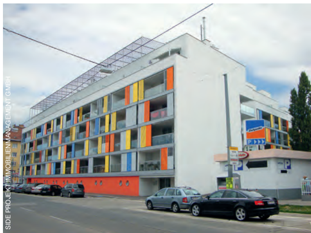
Auf dem Gelände einer ehemaligen Tankstelle, in der Simmeringer Hauptstraße in Wien, steht jetzt ein Wohnbau der GESIBA mit insgesamt 116 Wohnungen, ein Projekt von Side Projekt.
