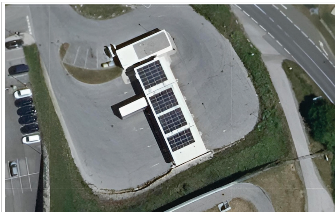
PV-Anlage (Quelle: earth.google.com )
