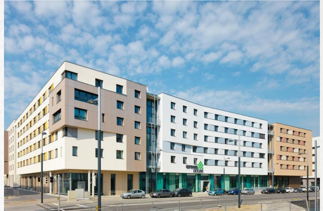
Bauherr: Wohnbauvereinigung für Privatangestellte Architektur: aap.architekten ZT-GmbH
