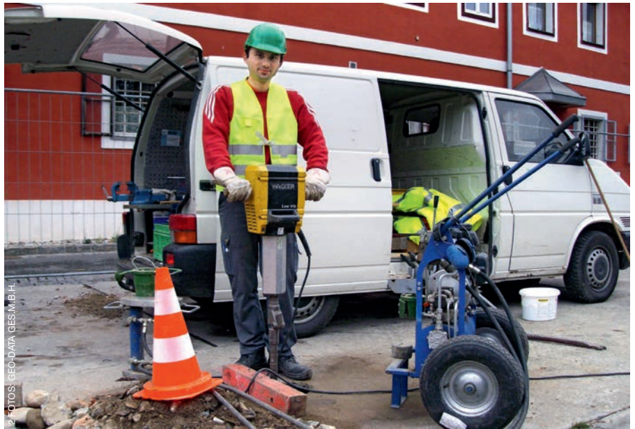
Mit Hilfe der Rammkernsondierung werden Bodenproben an signifikanten Stellen gezogen.
