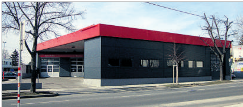
In der Jedleseer Straße in Wien-Floridsdorf wurde eine ehemalige Tankstelle in eine moderne Kfz-Werkstätte umgebaut. Foto: Side Projekt
